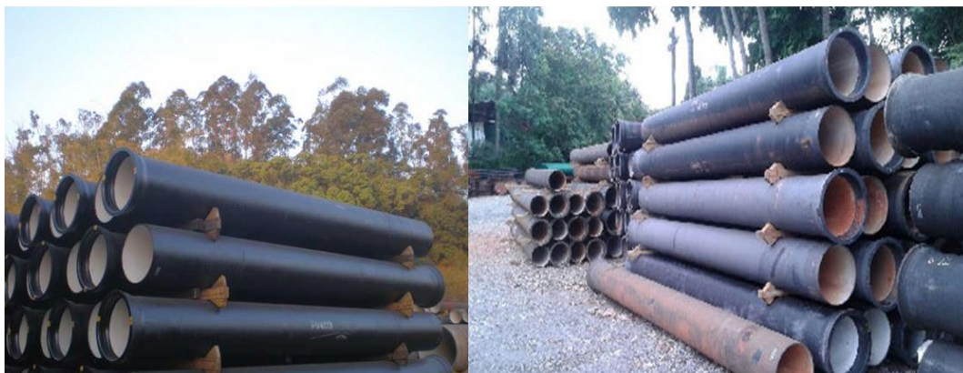
Figura 2: Acondicionamento e empilhamento de tubos de ferro fundido.
