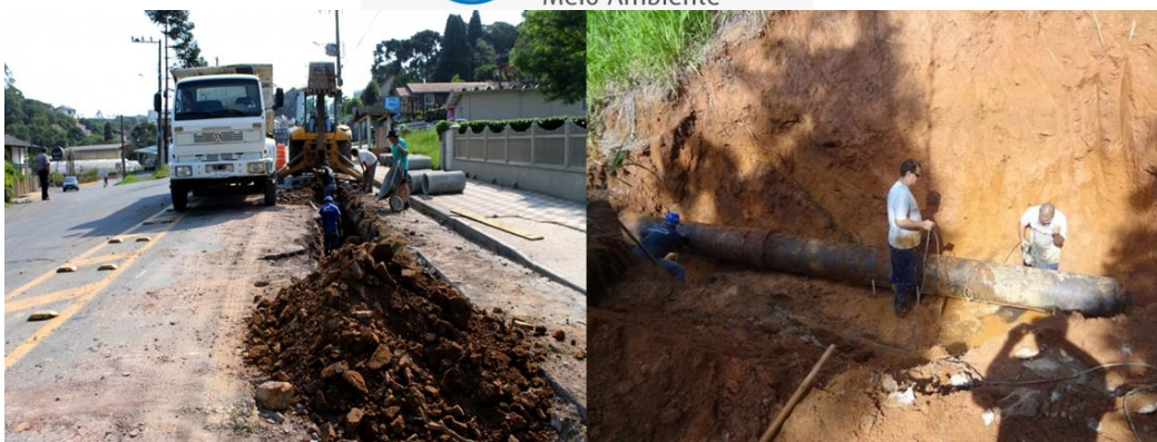
Figura 5: Processo de reparo e renovação das tubulações de ferro fundido.
