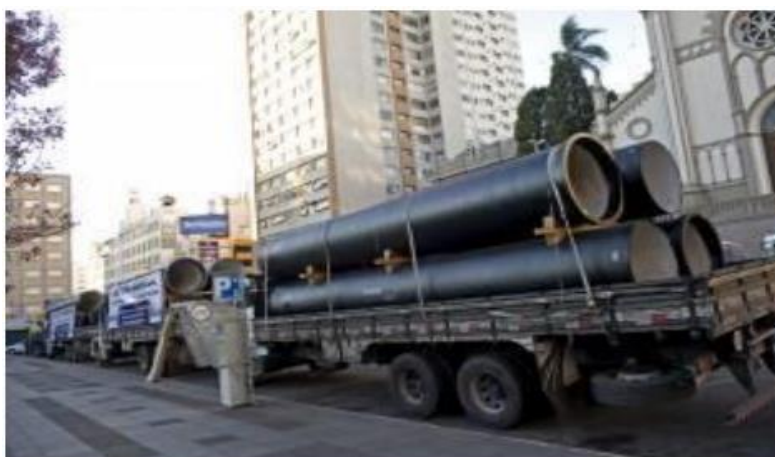
Figura 3: Estoques de tubos de ferro fundido com revestimento interno.
