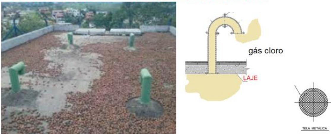
Figura 17: face superior da laje de cobertura de um reservatório com respiros para eliminação do gás cloro (fonte: google).
