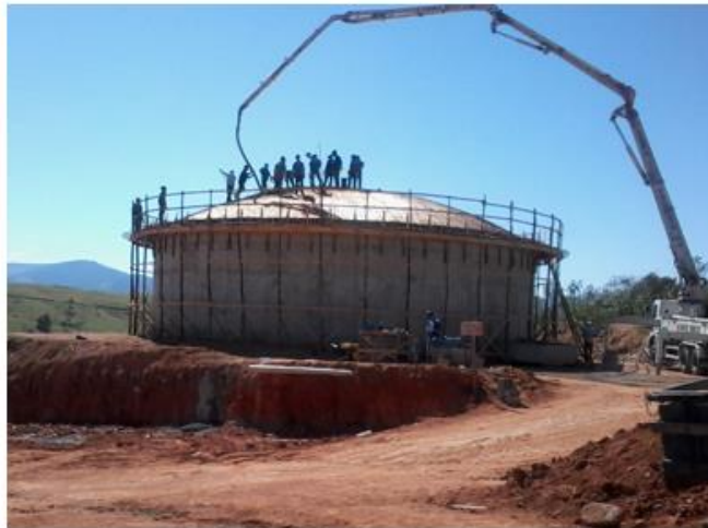
Figura 12: reservatório sendo construído (fonte – Sabesp)
