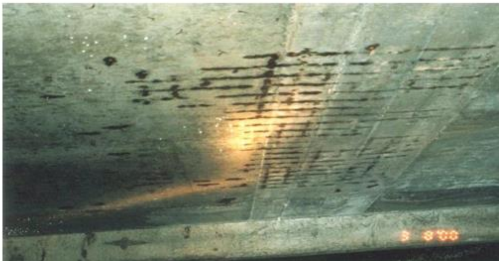
Figura 11: face inferior da laje de um reservatório de concreto armado com barras de aço oxidadas.
