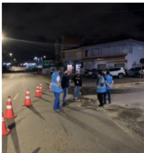
Foto 3 – Execução das Manobras de regulagem da Vazão de Entrada no Setor R7 – Step Test (Companhia Águas de Joinville, 2021)
