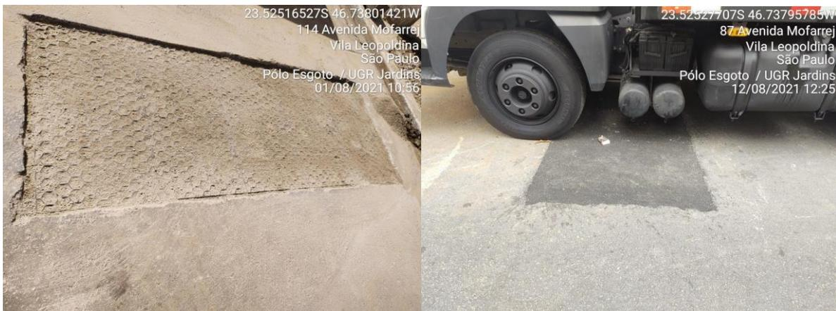
**Fotos 15 e 16: Utilização da Geogrelha, preenchimento de areia e asfalto quente**
