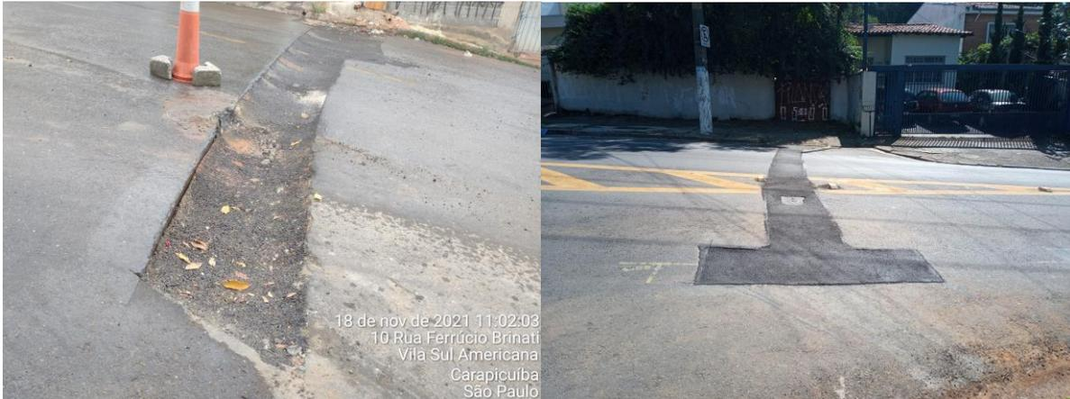
**Fotos 11 e 12: Reposições de valas executadas sem a utilização da Geogrelha**
