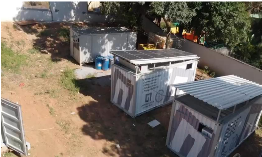
Figura 9 - Visão geral dos containers
