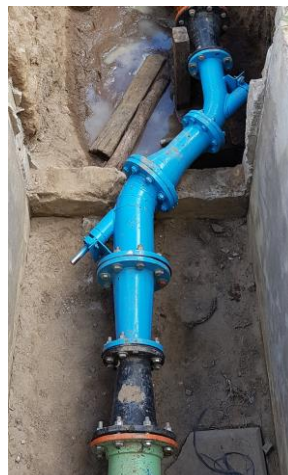
Figura 03: Instalação no SIAA de Cruz das Almas.
