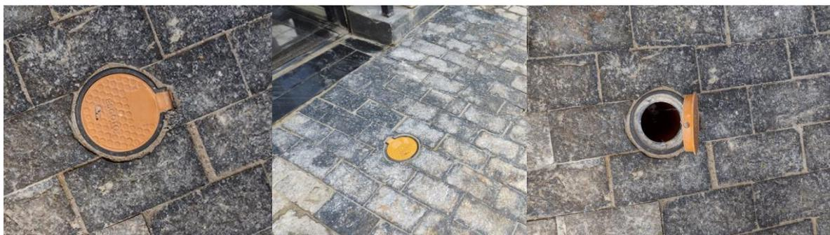
**Imagens 6, 7 e 8: Instalação do Tampão Termoplástico**
