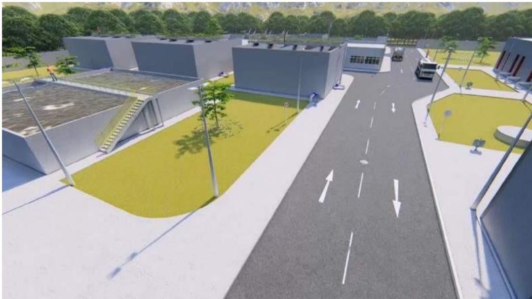
Figura 5: Vista dos Tanques de Aeração e Casa dos Sopradores
