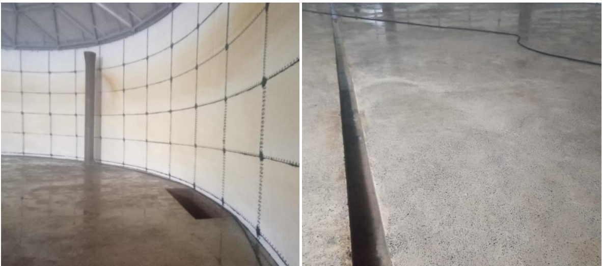
Figura 19: Reservatório Savoy após lavagem
