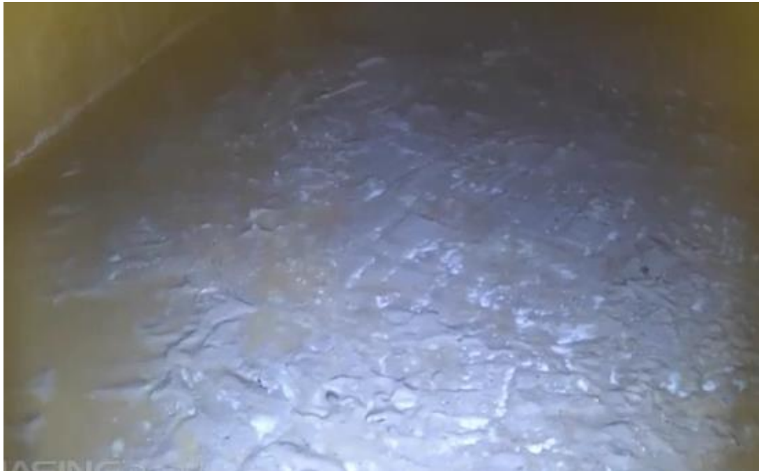
Figura 9: Imagem de lodo depositado no fundo do reservatório
