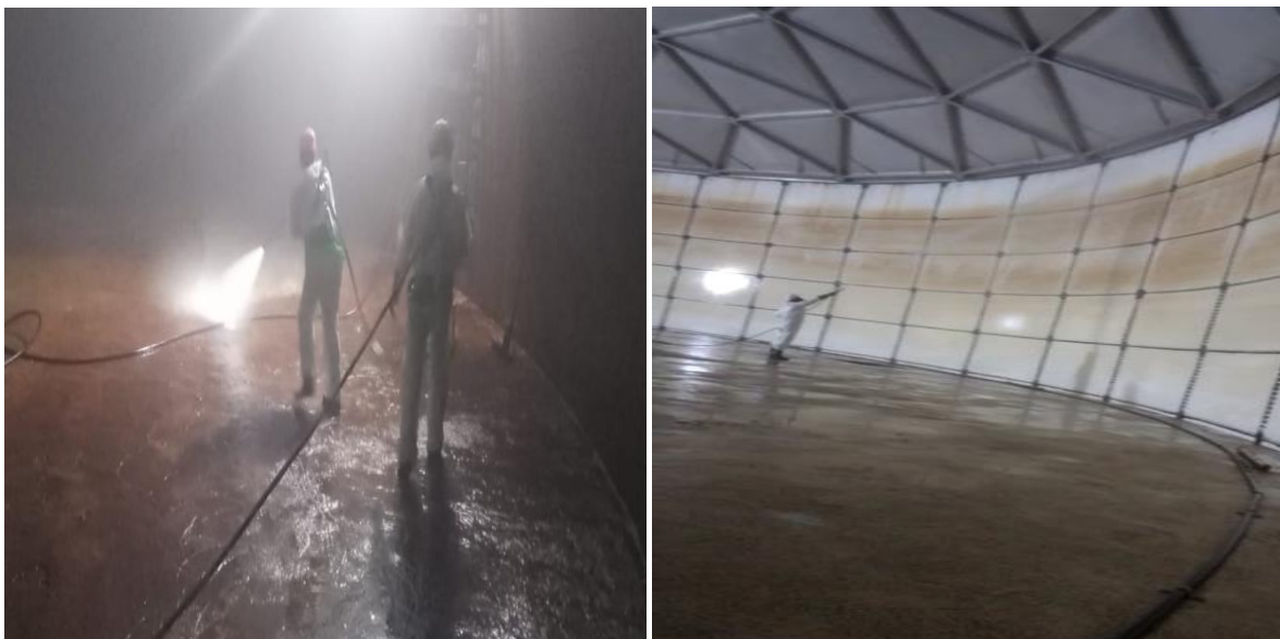
Figura 15 e 16: Lavagem de reservatório – CRAT Ferraz de Vasconcelos e Savoy (SP)
