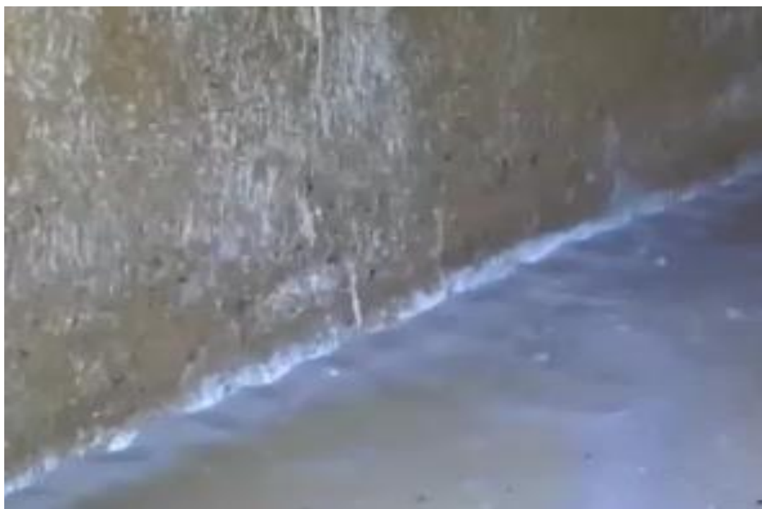
Figura 12: Imagem da parede do reservatório
