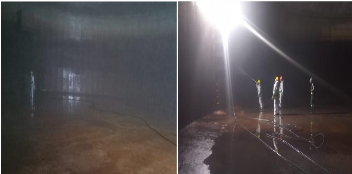
Figura 13 e 14: Lavagem de reservatório – CRAT Ferraz de Vasconcelos
