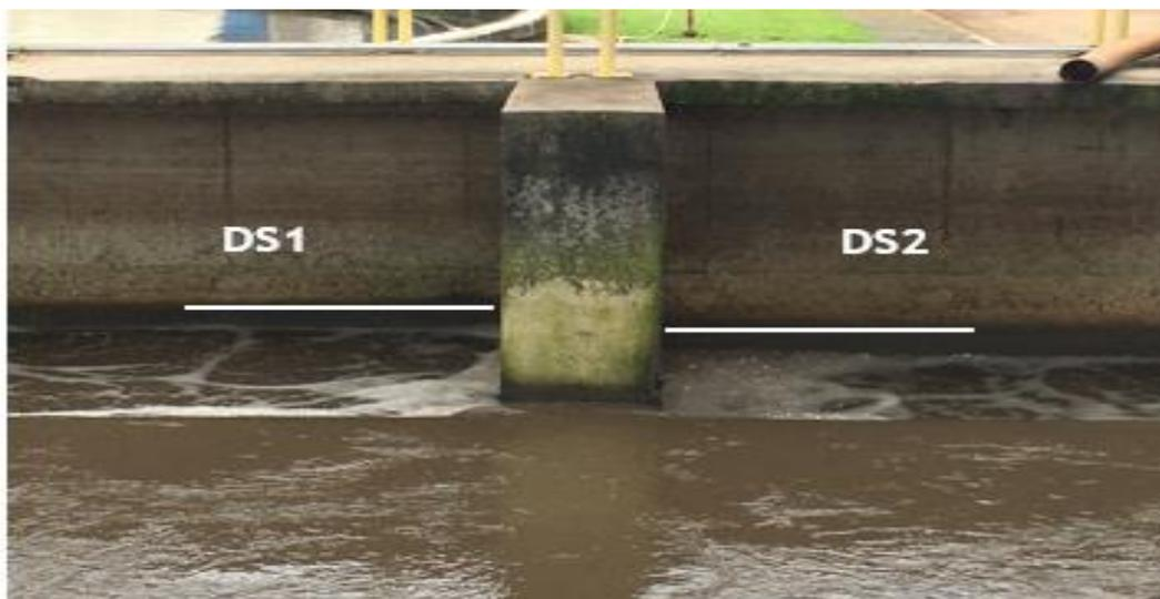
**Figura 13: Desigualdade na vazão distribuída**
