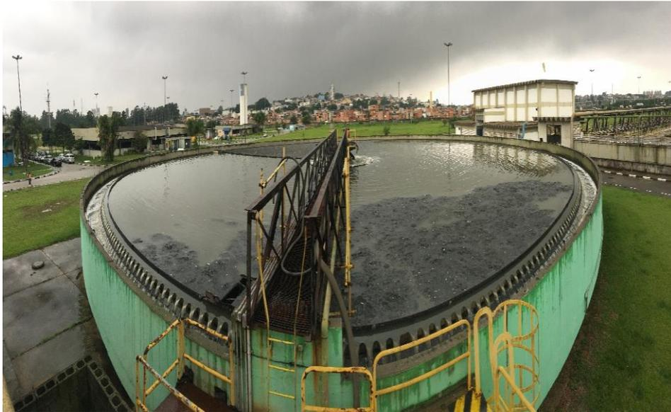
**Figura 3: Decantador primário sobre stress**
