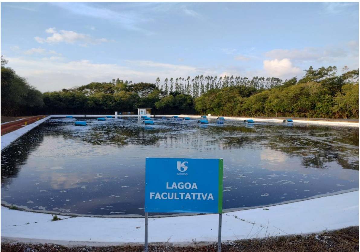
Figura 10: Nova placa de identificação para a lagoa facultativa.
