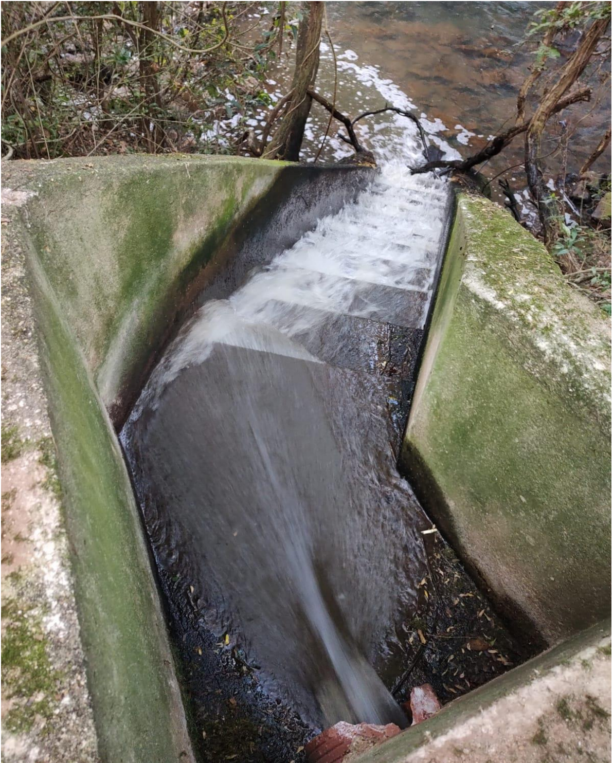
Figura 14: Lançamento no corpo receptor após a instalação e funcionamento dos aeradores na lagoa facultativa.
