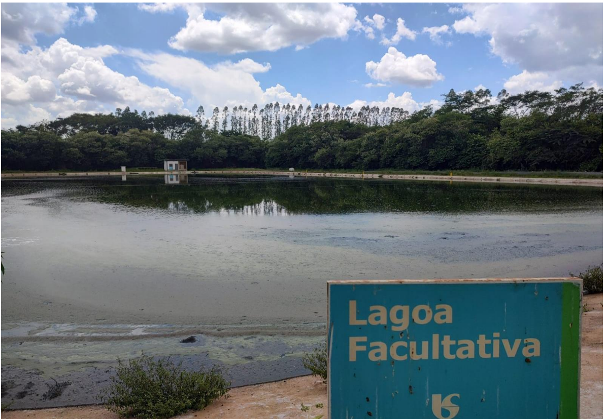
Figura 9: Lagoa facultativa antes da instalação dos aeradores e revitalização da área.
