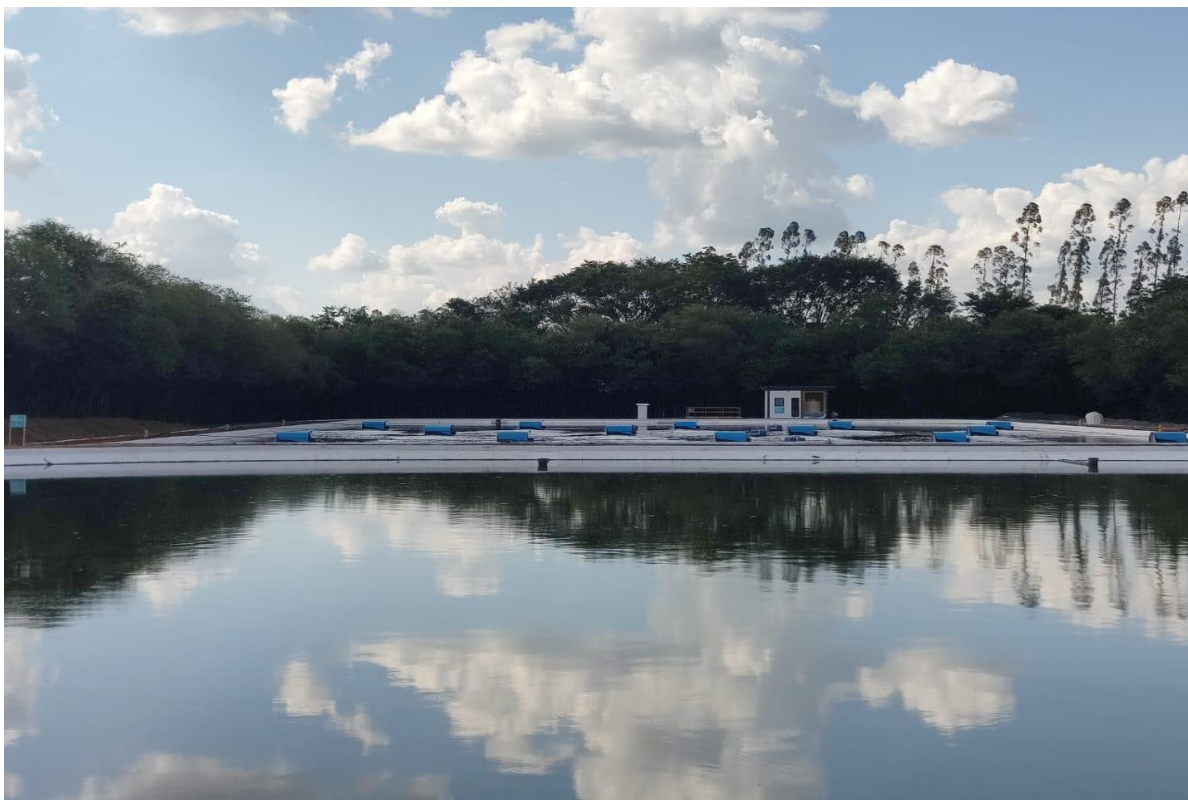
Figura 7: Lagoas de estabilização: Anaeróbica e Facultativa após os trabalhos de revitalização e instalação dos aeradores.
