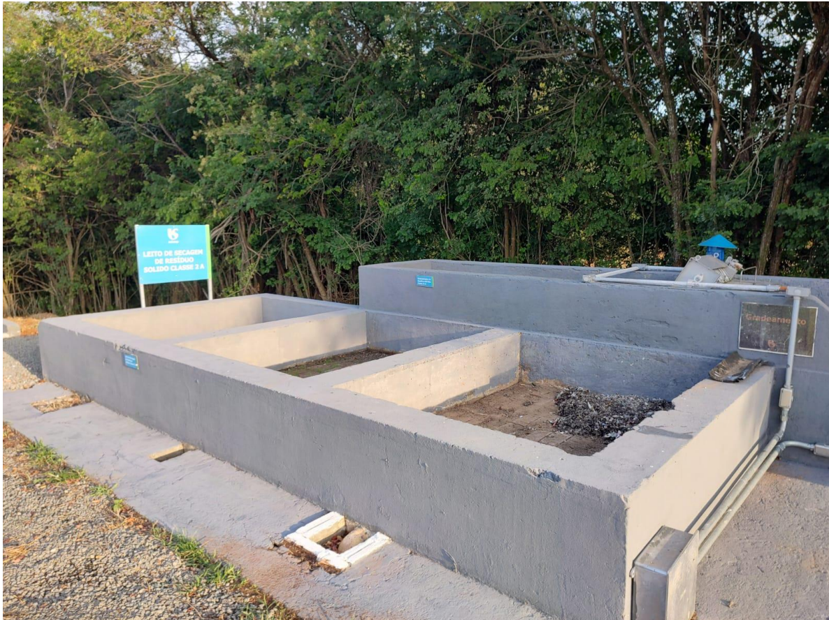
Figura 5: Leitões de secagem para resíduos sólidos provenientes dos sistemas de gradeamento fixo e peneira rotativa.
