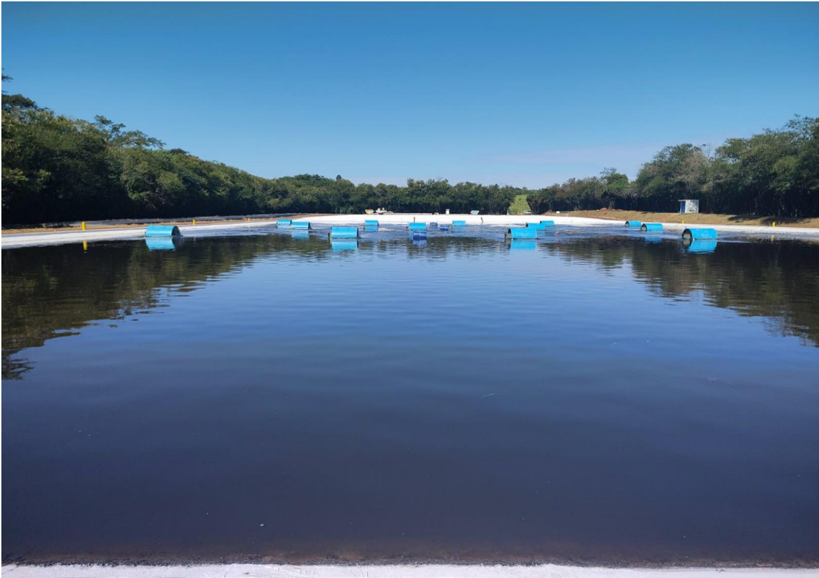
Figura 11: Lagoa facultativa após funcionamento dos 14 aeradores.
