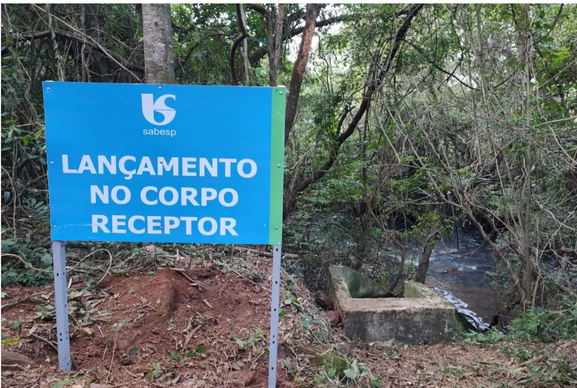
Figura 13: Identificação do lançamento no corpo receptor.
