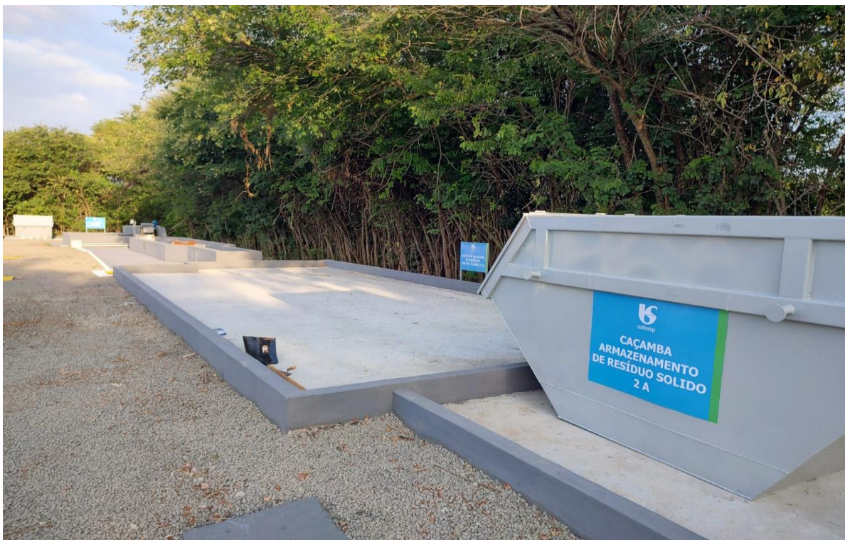
Figura 2: Caçamba para resíduos sólidos classe IIA e leito de secagem para areia e sobrenadantes.
