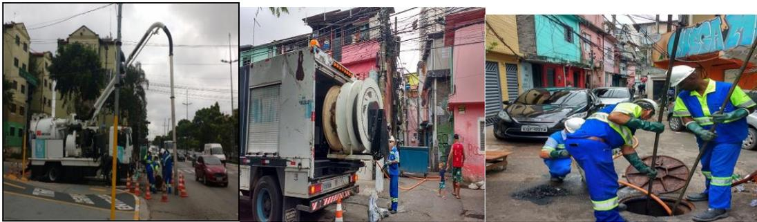
**Figuras 11 – Limpeza de rede Coletora**
