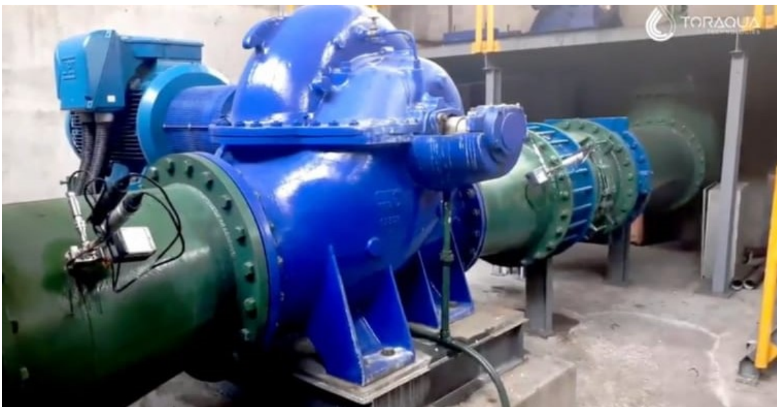
Figura 3 - Equipamentos para medição do rendimento da bomba instalados nos pontos de tomada na tubulação de sucção e recalque da bomba.
