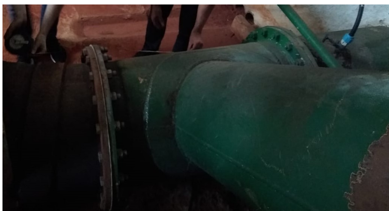
Fig. 4 – Conexão imediatamente a jusante do ponto de medição com o ultrassônico. Pode ser visto no canto inferior direito a superfície lixada, que é a pista onde foi instalado o medidor ultrassônico.
