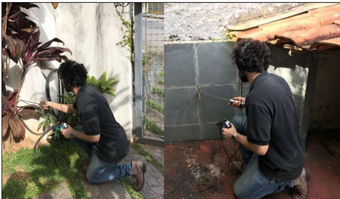
Figura 1 – Técnico realizando varredura em rede de água para a detecção do vazamento.
