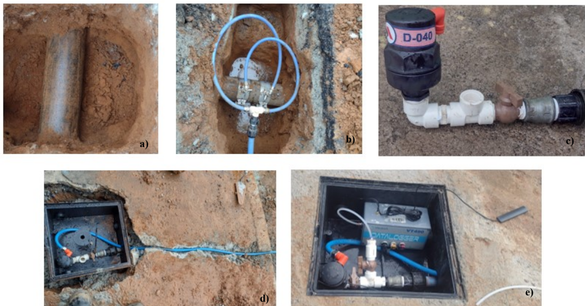
Figura 05 – Instalação caixa no passeio. Fonte: Sabesp (2022)
