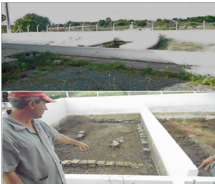
Figuras 3 e 4: Vista geral dos leitos drenantes (superior) e obra de manutenção dos leitos drenantes na ETA Marruás dos Rosas (inferior). Fonte: CAGECE (2022) adaptado.
