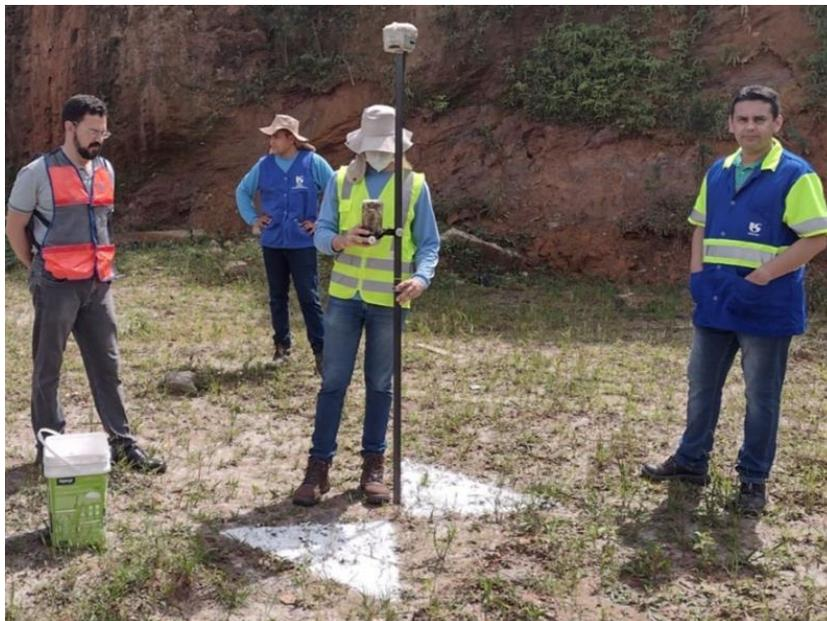
**Figura 2: Coleta de ponto de apoio com receptor GPS do tipo “Rover”. Fonte: Sabesp (2022)**
