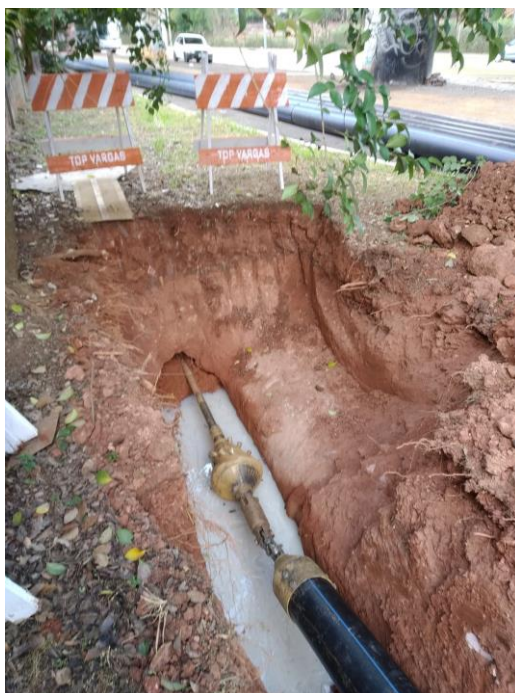
Figura 2 – Extensão de rede DE 250 através do Método Não Destrutivo. (Fonte: próprio autor).
