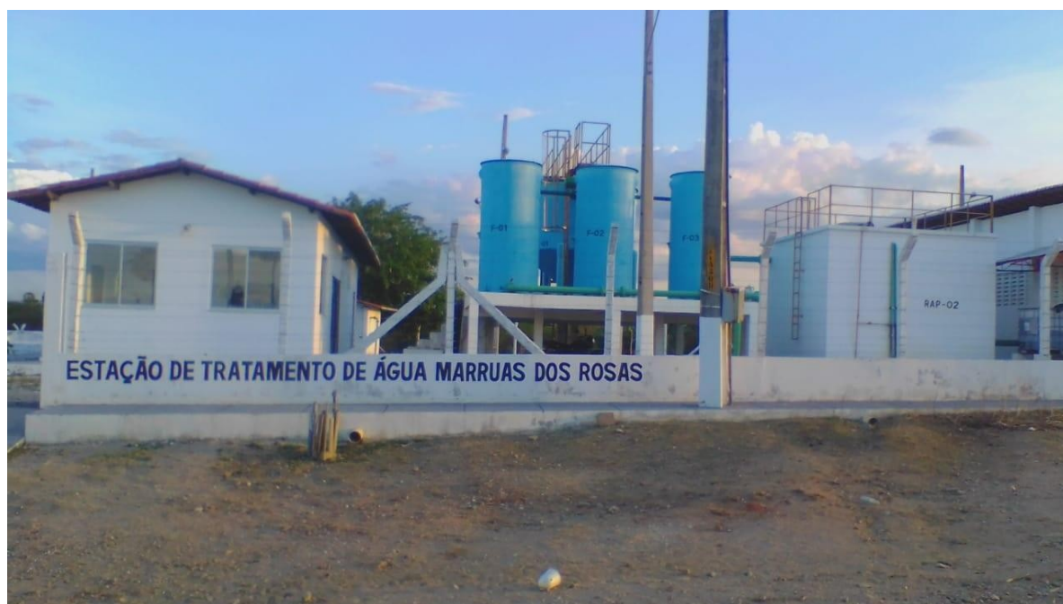
Figura 1 — Estação de Tratamento de Água Marruás dos Rosas.
