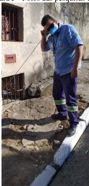
(a) Pesquisa de vazamento - haste de escuta
