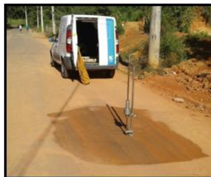
Figura 11: Utilização do Dinamic Cone Penetrometer – DCP para ensaios de compactação dos solos nas valas de assentamento das tubulações. Fonte: Sabesp, 2021
