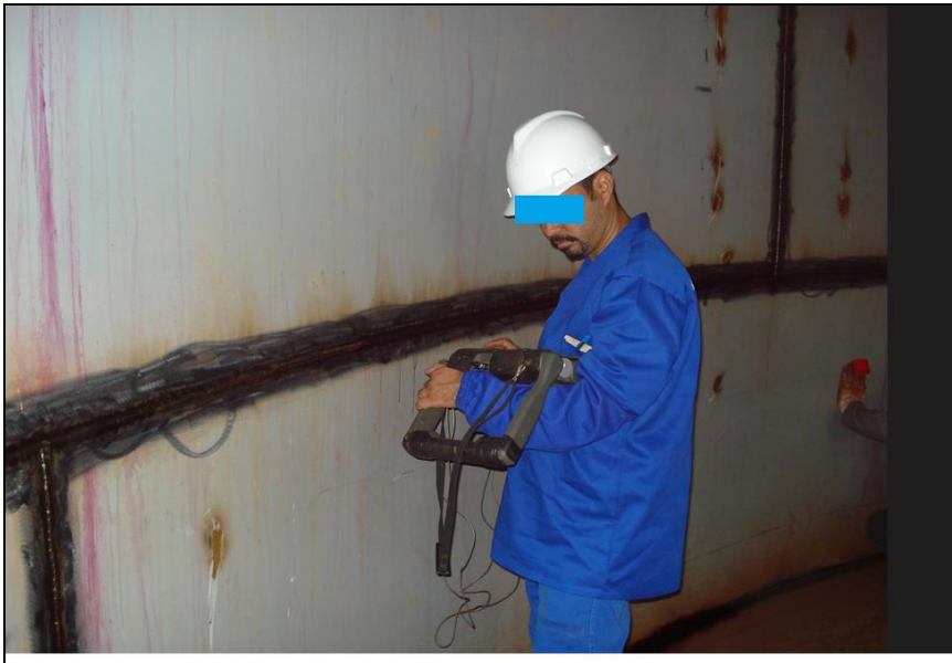
Figura 15: Ensaio de ultrassom no reservatório metálico Portal Bragança, município de Bragança Paulista. Fonte: Sabesp, 2010
