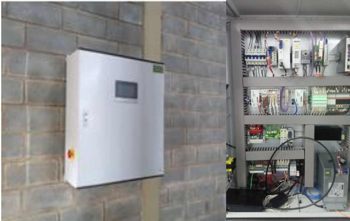
Figura 5 – Detalhe do PCE
