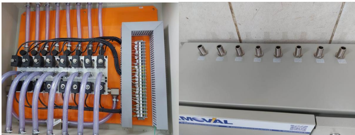
Figura 2 – Sistema de retrolavagem e detecção de amostras.
