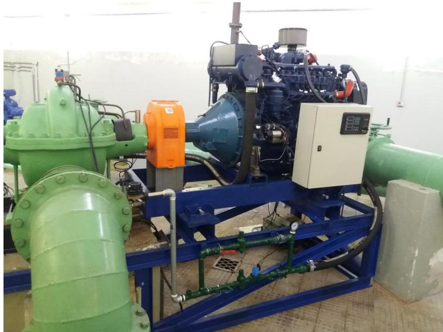
**Figura 2 - Motobomba acionada por motor a gás natural instalado na EEA VI. Alpina em 2018**
