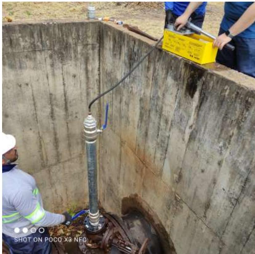
*Figura 2. Bomba manual utilizada para inserir pressão positiva*
