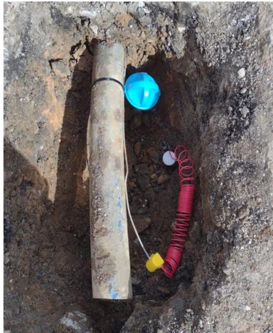
Esfera marcadora instalada próxima à luva de solda por eletrofusão na vala intermediária
