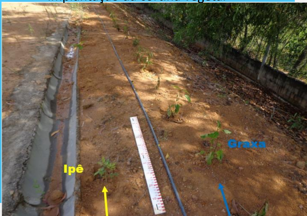
Instalação do sistema de irrigação e início da implantação da cortina vegetal
