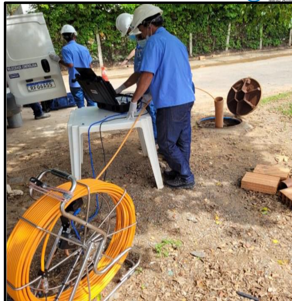
Uso da Câmera de Inspeção
