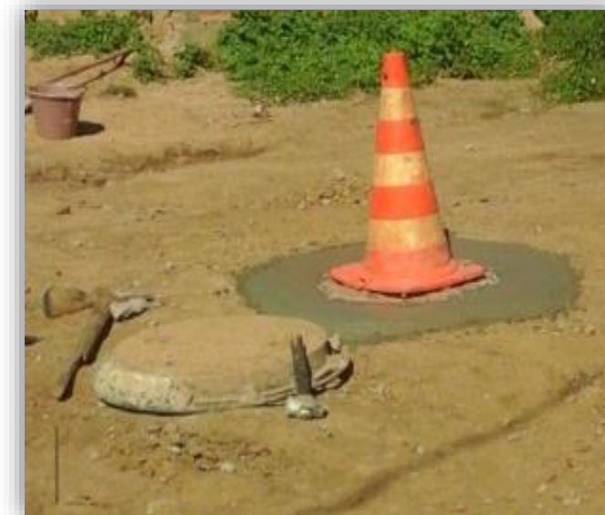
Manutenções em PV's
