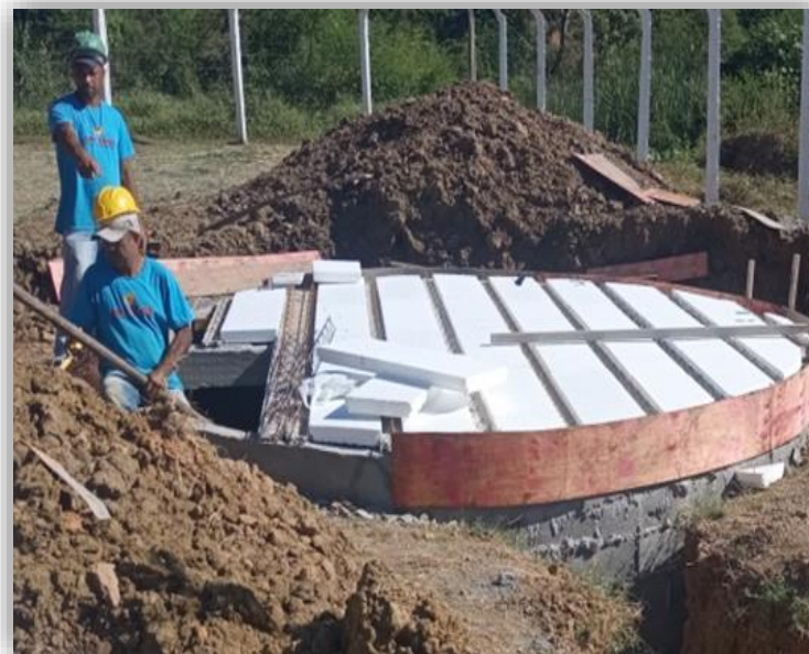
Construção de Tanque Pulmão
