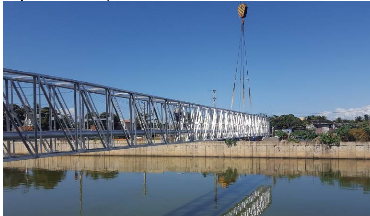
Figura 8 - Travessia apoiada em treliça metálica
