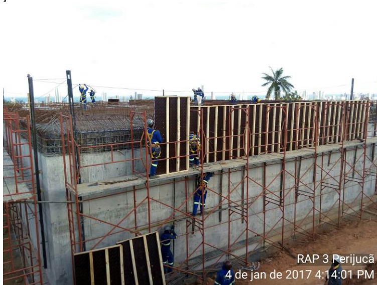
Figura 7 - Construção do reservatório
