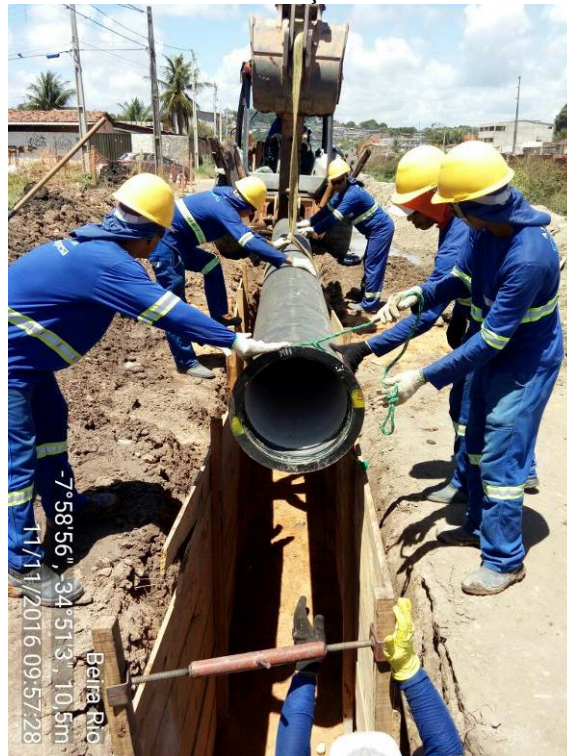
Figura 4 - Obra de assentamento de nova rede de adução
