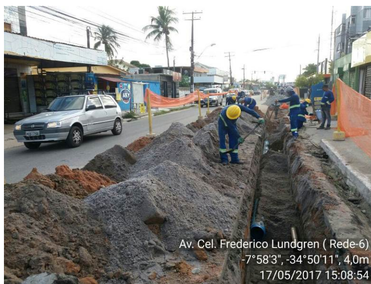
Figura 3 - Obra de assentamento de nova rede de distribuição
