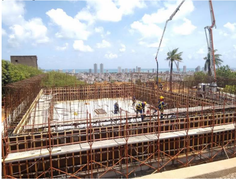
Figura 6 - Construção da laje de um dos reservatórios
