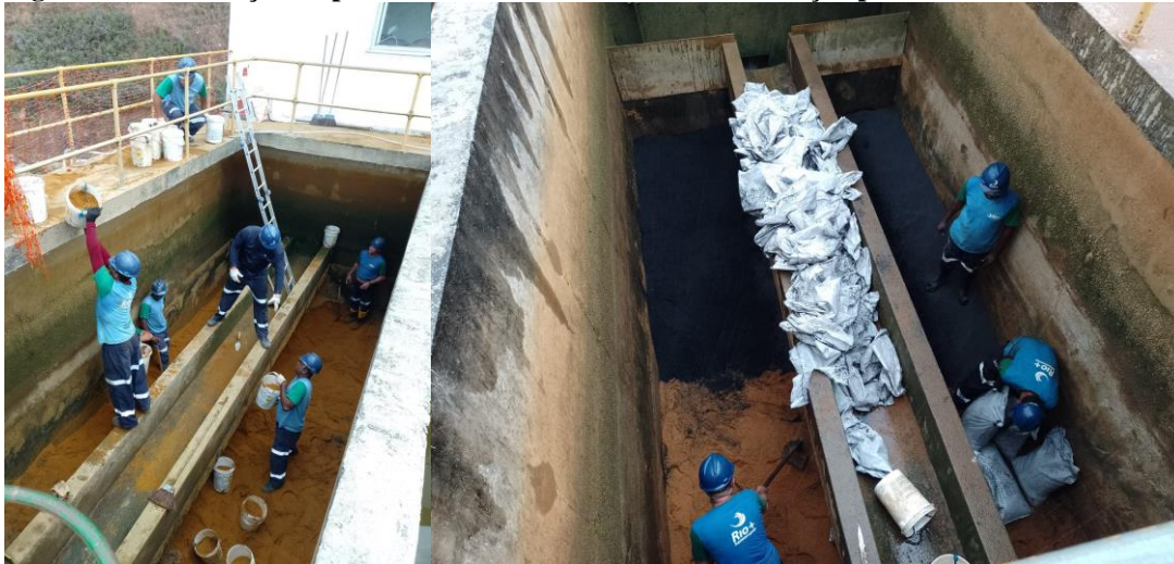
Figura 1 - Substituição de parte do leito filtrante areia e substituição por Antracito.
