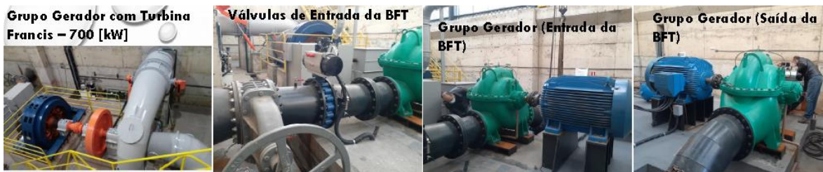
Sistemas Interligados na Rede (Geração Distribuída) – CGH São João – Carambeí-PR Queda – 34 [m]; Vazão – 1124 [L/s]; Potência – 300 [kW] – Operação desde 2021
