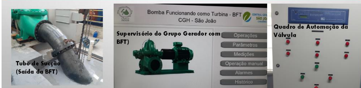
Sistemas Interligados na Rede (Geração Distribuída) – CGH São João – Carambeí-PR Queda – 34 [m]; Vazão – 1124 [L/s]; Potência – 300 [kW] – Operação desde 2021
