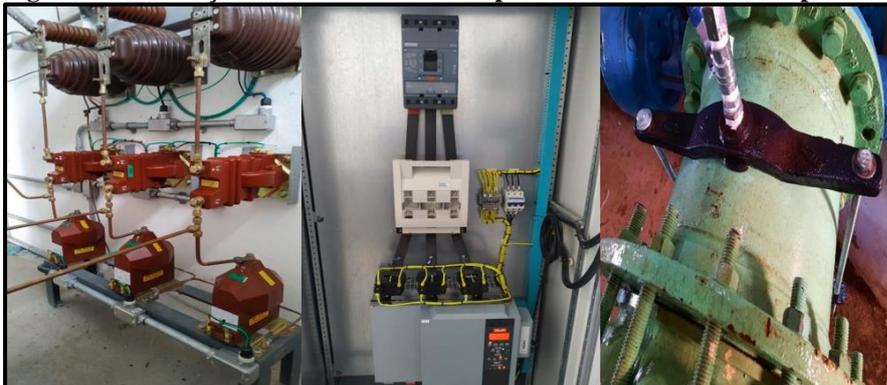
Para o monitoramento em acesso local e sistemas de supervisão, foram instalados multimedidores (Figura 7) nas estações de energia e centro de controles de motores. Esses multimedidores são dispositivos projetados para
