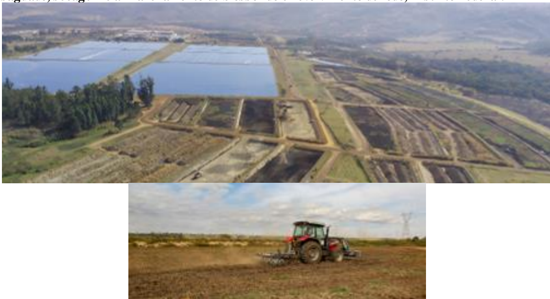
Figura 3 – Unidade de Gerenciamento de Lodo, UGL, com as fases de armazenamento de lodo desaguado, secagem e armazenamento de biossólido e revolvimento de lodo, Distrito Federal.
