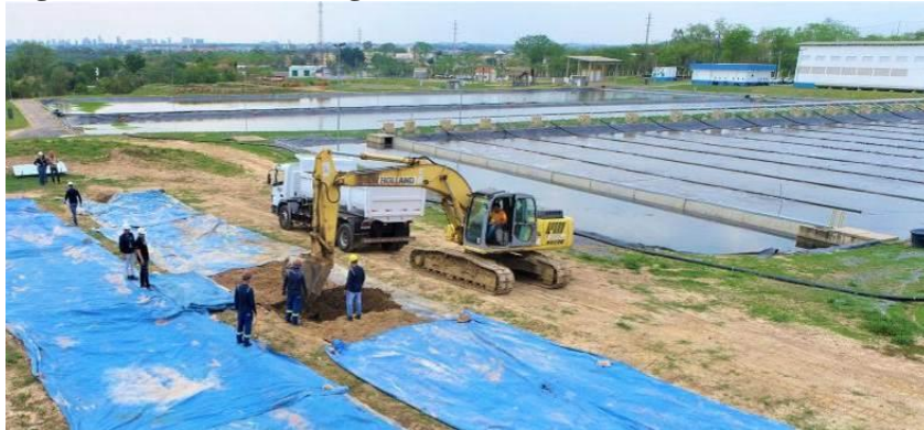
Figura 6 – Carregamento de biossólido, Águas de Cuiabá, Mato Grosso.
