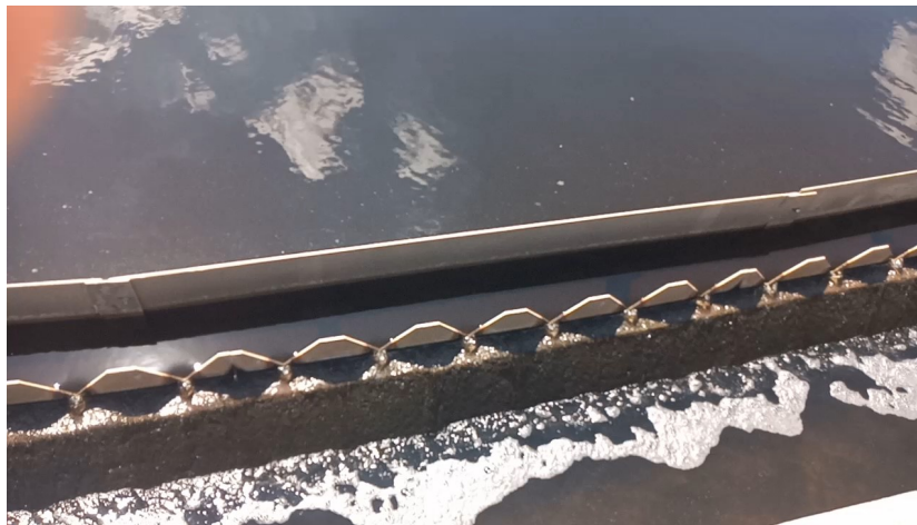
Figura 11 – Saída dos decantadores secundários sem arraste de sólidos
