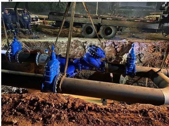
Figura 7: Instalação do barrilete VRP Dutra
