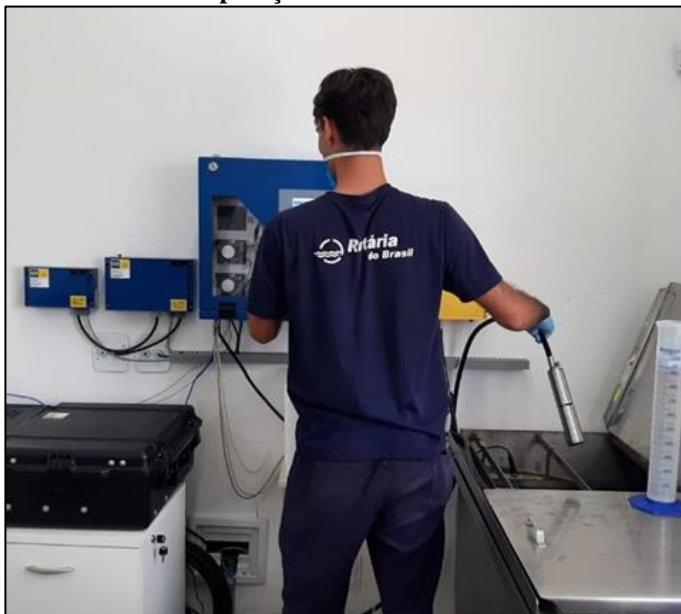
Figura 15 – Desligamento do sistema de limpeza automática de ar comprimido e limpeza da sonda UV/Vis na casa de operação – ETE do RS
