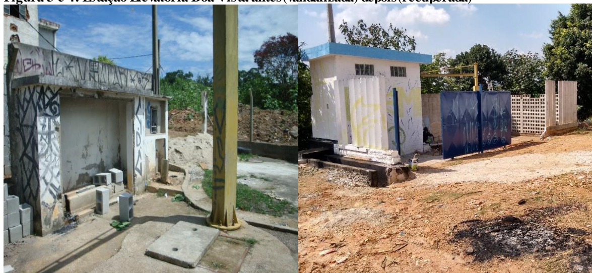
Figura 3 e 4: Estação Elevatória Boa Vista antes (vandalizada) depois (recuperada)
