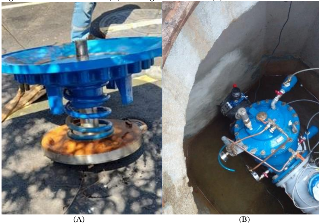
Figura 7 – Retirada das molas (A) e montagem das ventosas (B)
