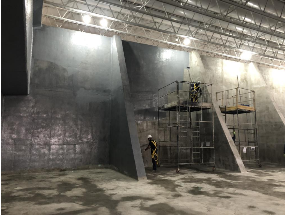
Figura 6 – Aplicação da resina epóxi.
