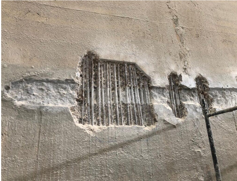
Figura 4 – Tratamento das falhas no concreto.
