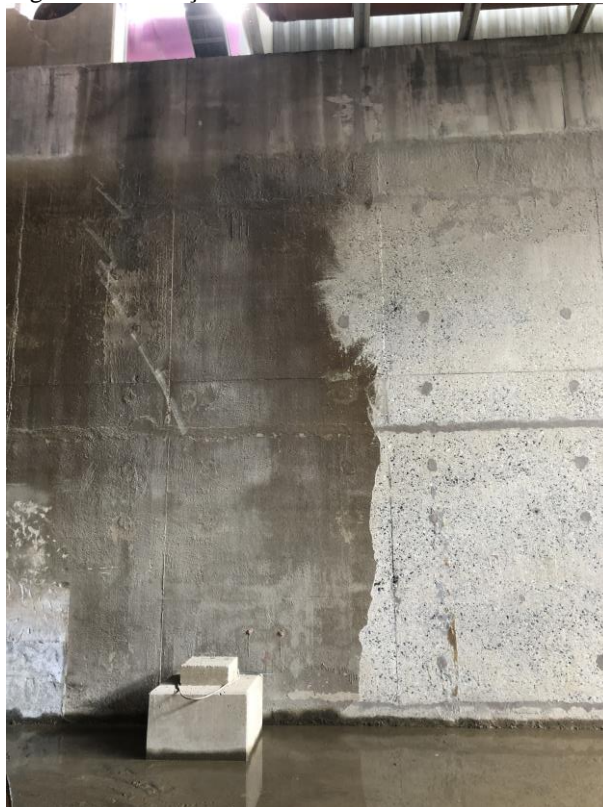
Figura 3 – Remoção da camada de concreto deteriorado.
