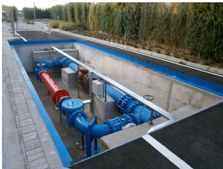
Imagem 2: Turbogenerador PERGA de 100 kW instalado na entrada da ETA de Griñón (Espanha)
