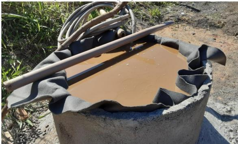
Figura 3 – Protótipo de Leito de Drenagem preenchido com lodo de ETA até 40 cm de altura.
