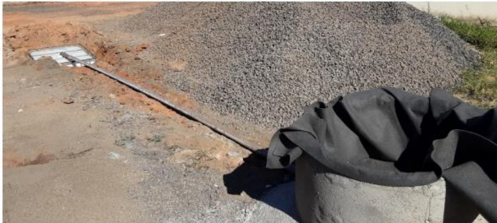
Figura 2 – Protótipo do leito de drenagem e tanque para acúmulo do líquido drenado.
