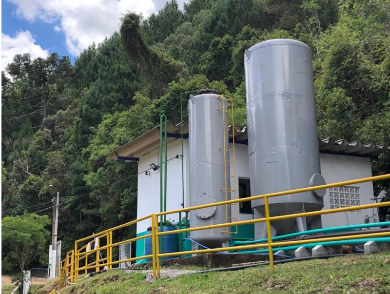
Figura 2- ETA compacta metálica implantada em 1980, sendo o decantador (estrutura metálica maior) e o filtro de dupla camada (estrutura metálica menor).
