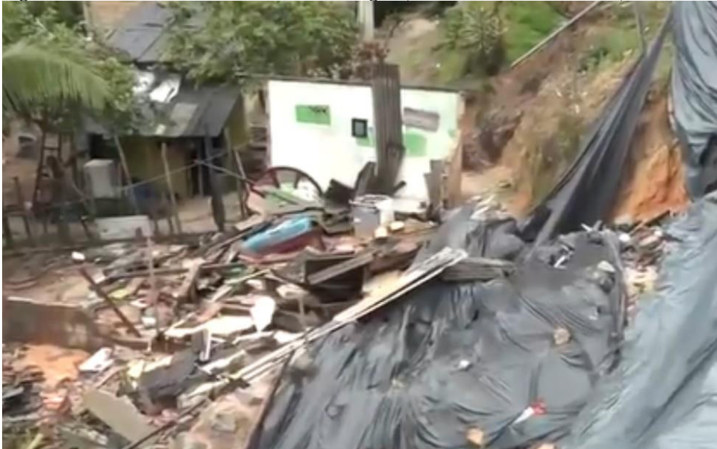
Figura 6 - Deslizamento de terra em Porto Seguro, no Extremo Sul da Bahia, em 14/12/2022
