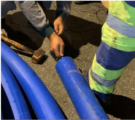
Figura 3 – Fixação do fio marcador no tubo a ser puxado.
