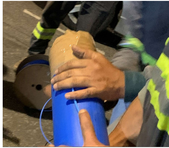
Figura 3 – Fixação do fio marcador no tubo a ser puxado.
