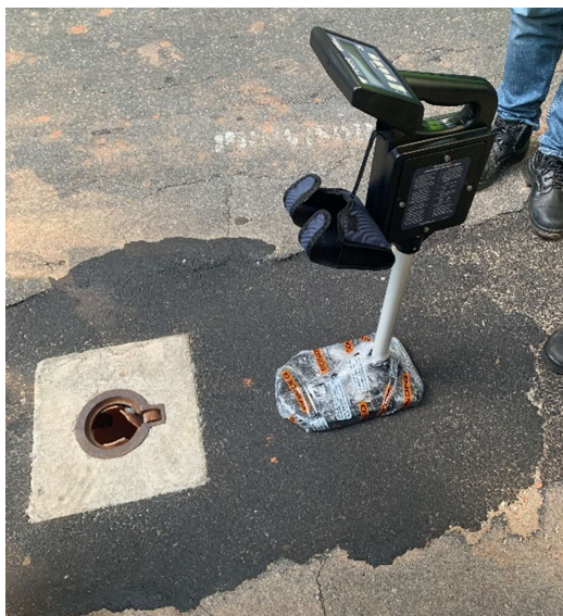
Figura 9 – Equipamento de detecção posicionado no local exato da esfera marcador instalada junto à luva de eletrofusão utilizada para união dos tubos na vala intermediária.
