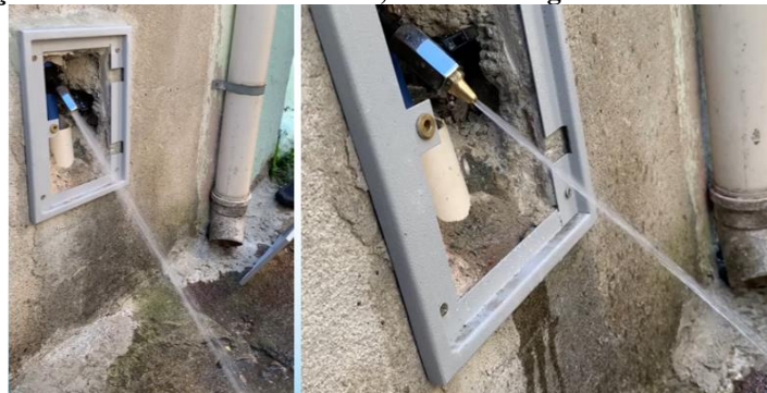
Figura 9 - Exemplo de local em que, devido à pressão alta, o fluxo era muito disperso (foto à esquerda). Com a instalação do bico orientador de fluxo, a coleta de água foi favorecida (foto à direita).
