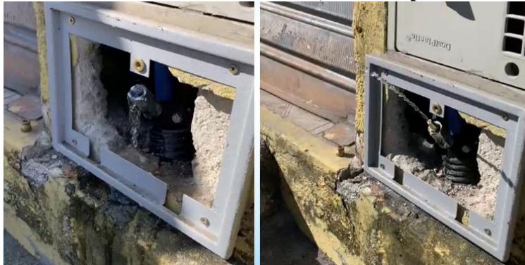
Figura 8 - Exemplo de caso em que a pressão era baixa e a UCQA havia sido instalada equivocadamente virada para cima. Com o bico orientador de fluxo, tornou-se possível realizar a coleta.
