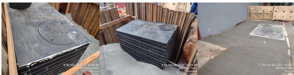
Fotos 6, 7 e 8: Instalação Caixa de Polímero Composto.
