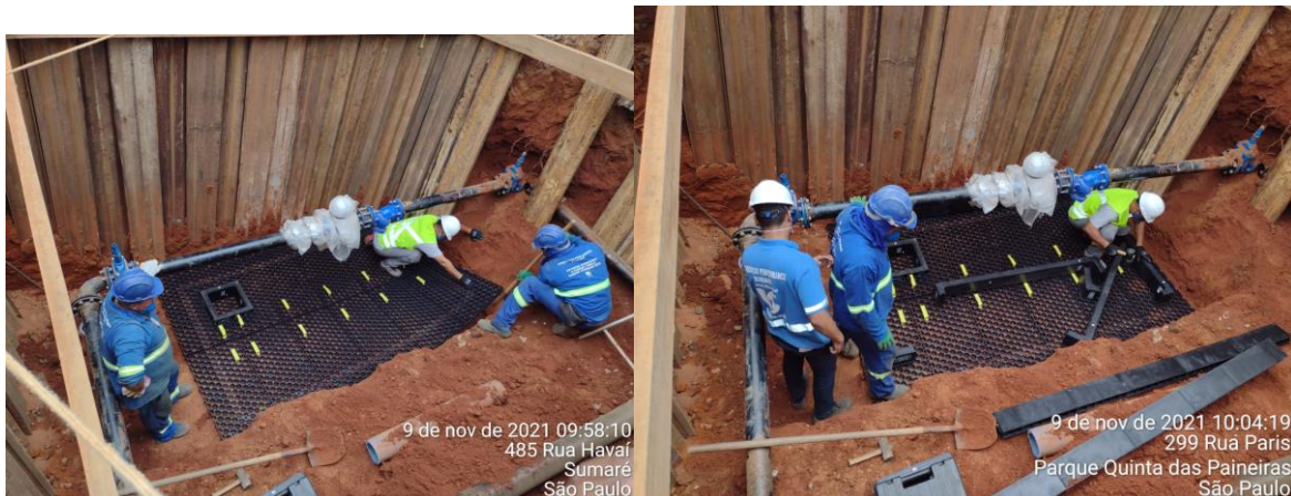
Fotos 1 e 2: Instalação Caixa de Polímero Composto.
