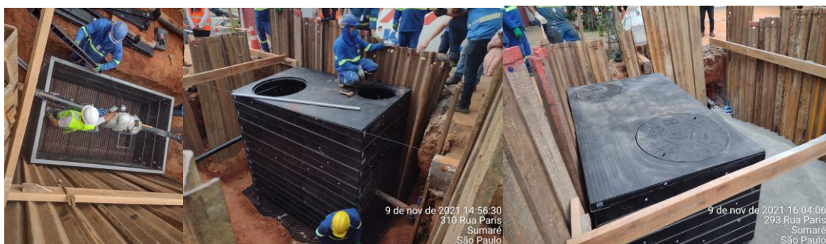
Fotos 3, 4 e 5: Instalação Caixa de Polímero Composto.
