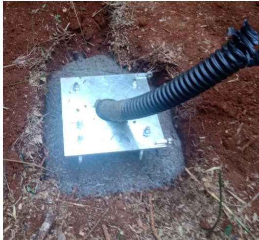
Figura 4a - Instalação da base do Quadro de Controle e Automação.
