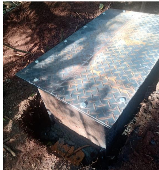
Figura 4d - Caixa de passagem do cabeamento da sonda, dificultando furtos e vandalismos.
