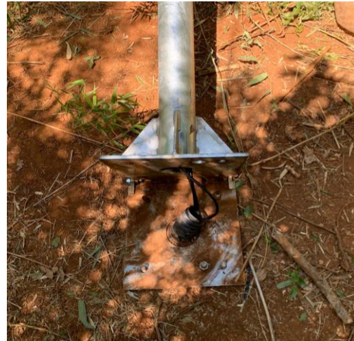
Figura 4.b - Base do Quadro de Controle Flexível.
