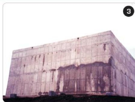
Portanto, é sempre necessário considerar tratamentos específicos para trincas, brocas e juntas de concretagem, caso não seja especificada uma proteção geral à estrutura. É ainda importante colocar que fissuras por ação de cargas, independente dos cuidados de concretagem e cura, vão ocorrer em concretos com altas resistências, módulo de elasticidade e aços de elevada resistência como CA50 e CA60.
