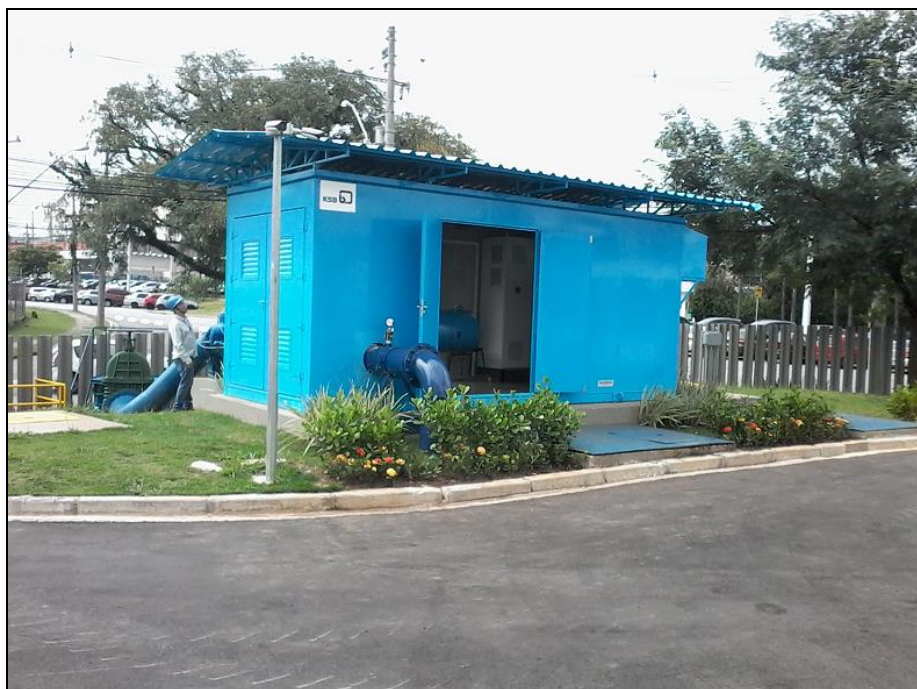
Figura 13: Vista da BFT Tamboré (vista para o logradouro) (fonte: Sabesp-2018).
