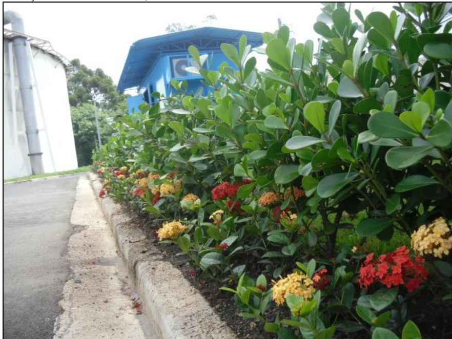
Figura 12: Vista da BFT Tamboré (entrada de reservatório (fonte: Sabesp-2018)).
