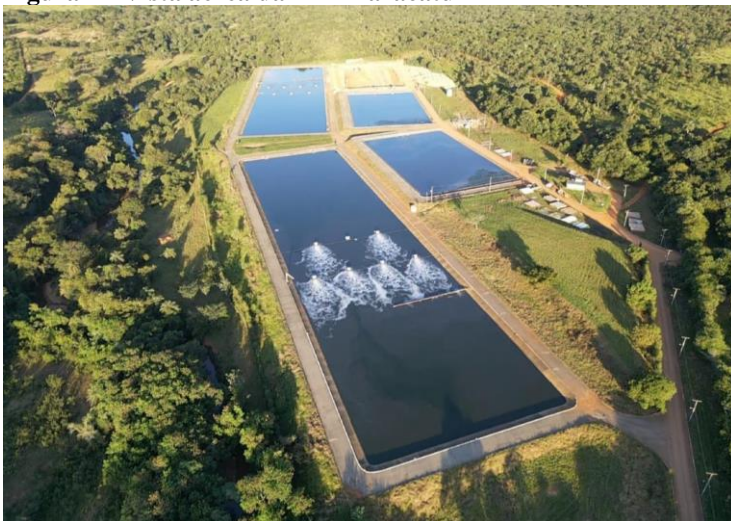
Figura 1 - Vista aérea da ETE Paracatu
